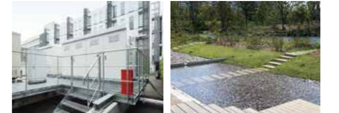
エネルギーマネジメントシステム
